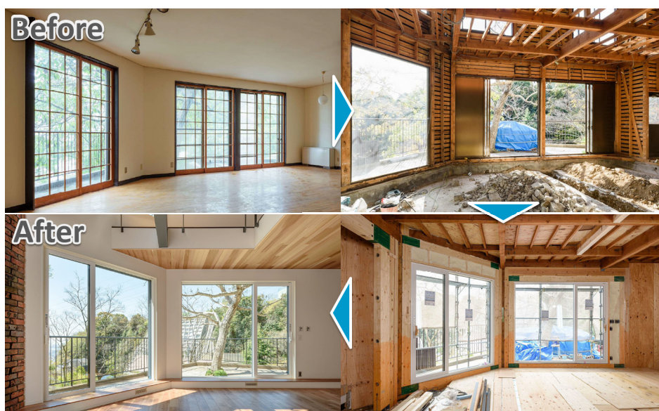
「フレーム II」設置箇所の Before⇒解体時⇒施工中 ⇒After の様子
